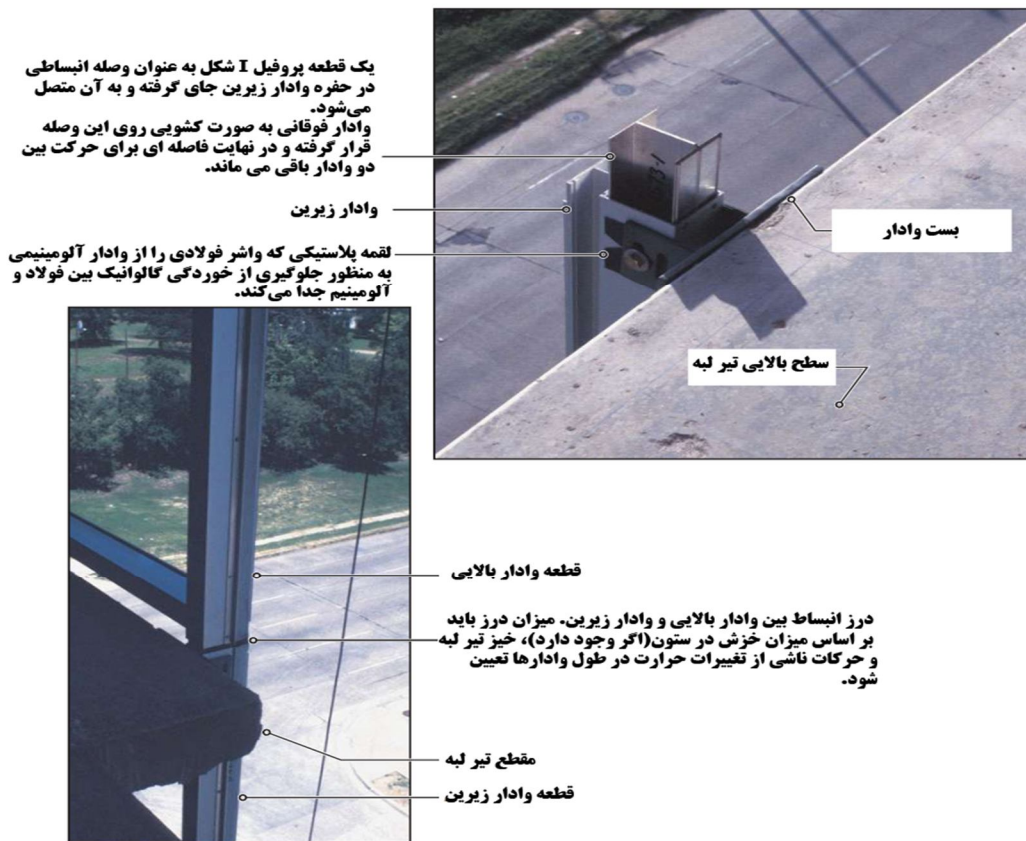
شکل ۸-۸- نمونه اتصال انبساطی بین دو قطعه وادار
