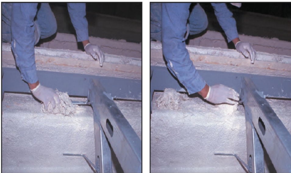
شکل ۶-۴۳- ساختن لایه‌های پیوندی
