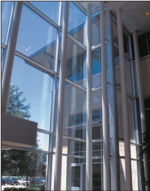
شکل ۸-۱۵- دیوار پرده‌های بلند، جهت تامین مقاومت جانبی به قاب فولادی سازه متصل شده است
