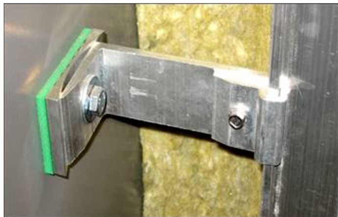
شکل ۶-۴۶- نمونه قطعه اتصال سپری‌های آلومینیومی به دیوار با امکان تنظیم در جهات و زوایای مختلف
