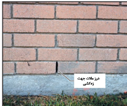
شکل ۵-۱۵- خالی گذاشتن درز ملات جهت زه‌کشی
