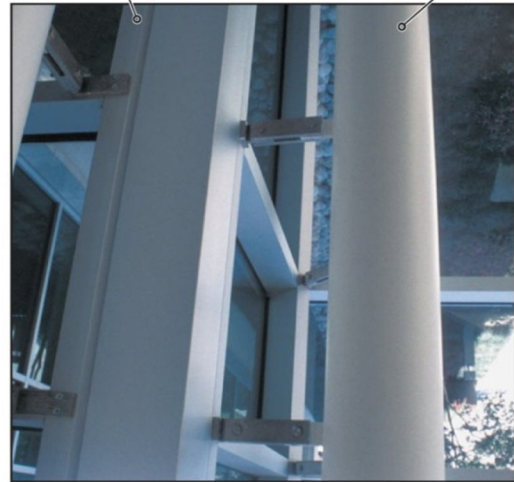
شکل ۸-۱۵- دیوار پرده‌های بلند، جهت تامین مقاومت جانبی به قاب فولادی سازه متصل شده است
