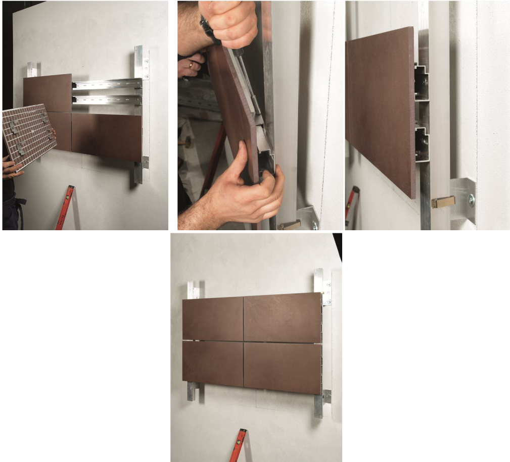
شکل ۷-۳۱- مراحل نصب سیستم نصب پنهان
