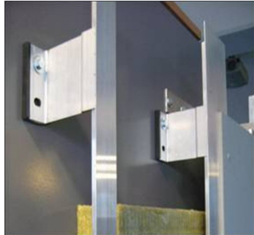
شکل ۶-۴۵- نمونه‌های زیرقاب ساخته‌شده با قطعات آلومینیومی
