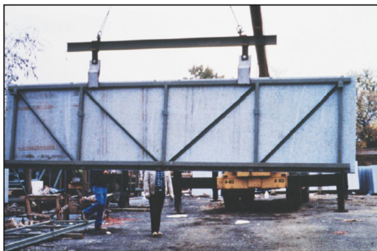
شکل ۴-۲۵- پانل دیواری پرده‌ای پیش‌ساخته سنگی
