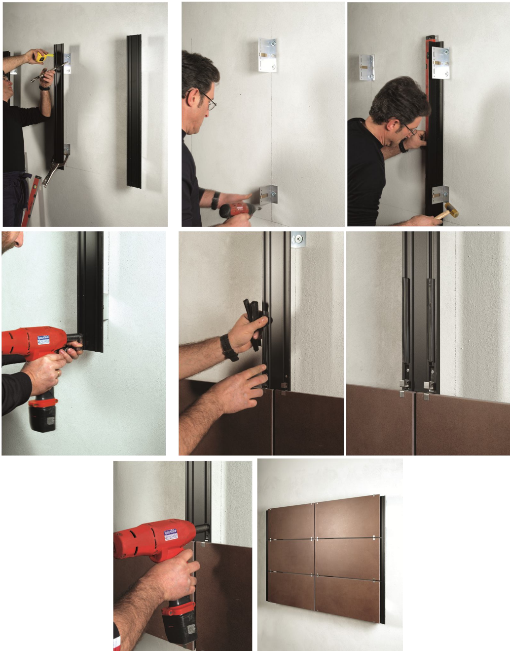
شکل ۷-۲۴- مراحل نصب سیستم نصب نمایان
